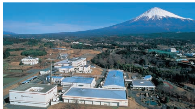
フジヤマ工場
