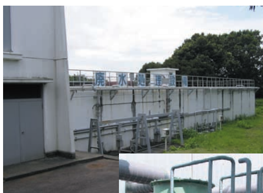
フジヤマ工場廃水処理設備
