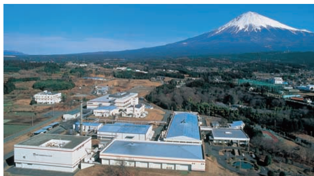
フジヤマ工場
