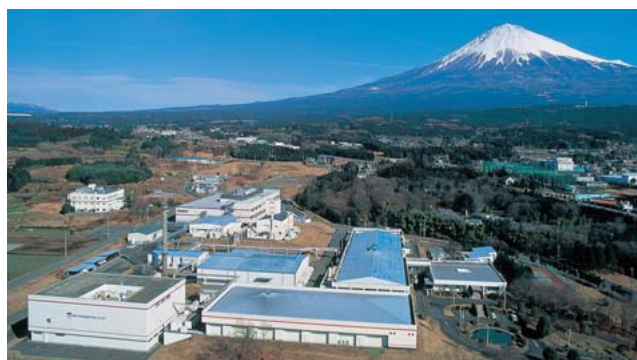
フジヤマ工場
