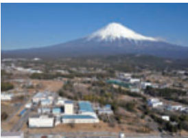
フジヤマ工場
