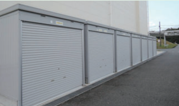
フジヤマ工場 廃棄物置き場
