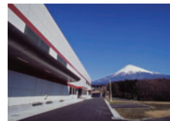
フジヤマ工場
