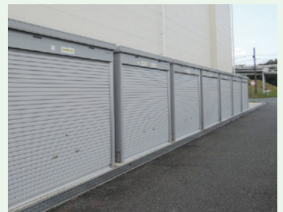
フジヤマ工場 廃棄物置き場
