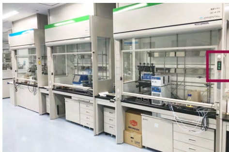
低風量型（プッシュ・プル型）超高速VAV（可変風量）式局所排気装置（操作パネル上で排気ファン出力の見える化）（水無瀬研究所）
