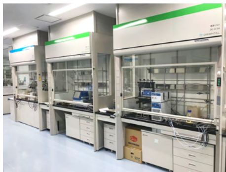
低風量型（プッシュ・プル型）超高速VAV（可変風量）式局所排気装置（水無瀬研究所）
