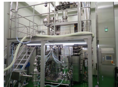
当社連続生産設備（フジヤマ工場）
