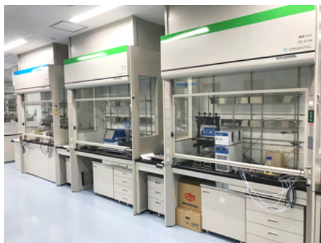
低風量型（プッシュ・プル型）超高速VAV（可変風量）式局所排気装置（水無瀬研究所）
